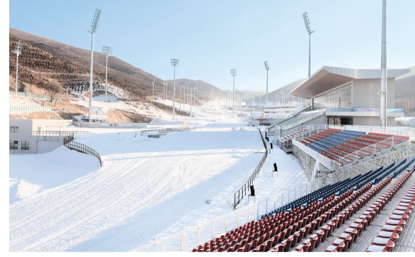
这是12月14日拍摄的正在塑型中的北京2022年冬奥会张家口赛区国家冬季两项中心赛道。近日,北京2022年冬奥会张家口赛区国家冬季两项中心的赛道开始塑型,测试活动的多项准备工作也全面展开,以迎接于28日至31日举行的“相约北京”系列测试活动冬季两项国际训练周。据介绍,在为期4天的冬季两项国际训练周期间,工作人员将对赛道、靶场、打蜡房等相关设施展开测试。新华社记者 杨晓亮摄
