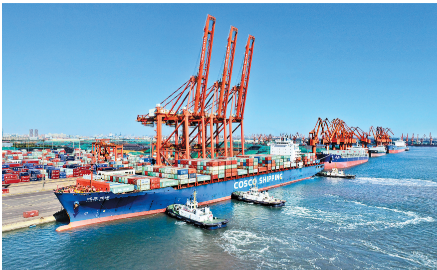
10月23日,一艘轮船在拖轮的协助下向唐山港曹妃甸港区集装箱码头靠泊(无人机照片)。 新华社记者 朱旭东摄
