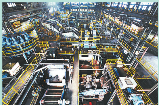
选煤厂主洗车间。
