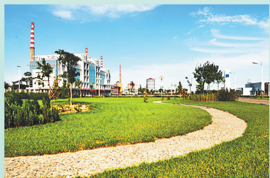
建成后的中润煤化工园区。
