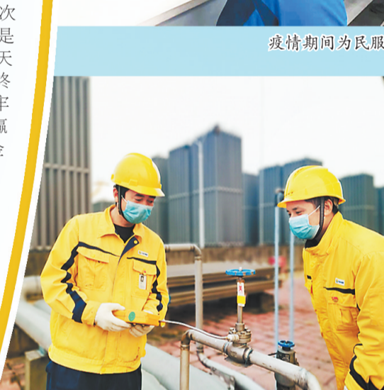
场站管线巡检。
