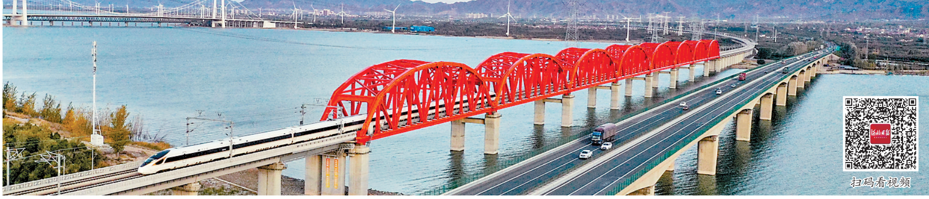
张家口市怀来县京张高铁官厅水库特大桥。(本报资料片)
