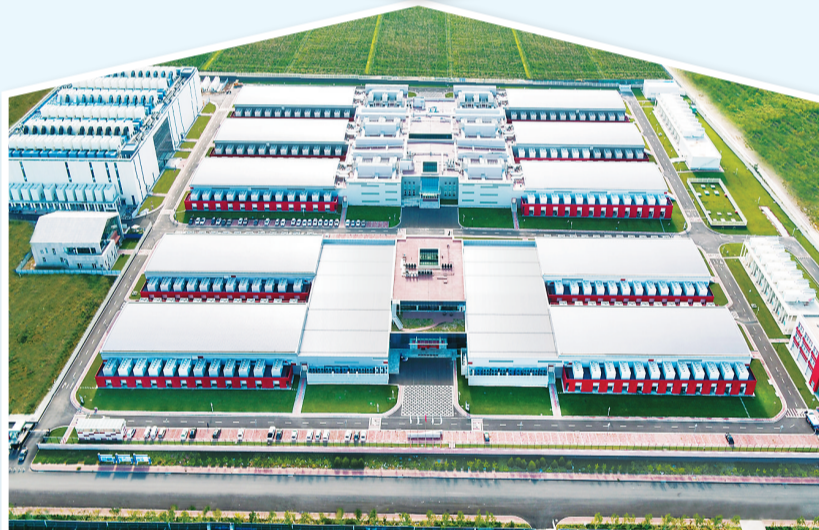
上图:张北阿里巴巴云计算基地项目机房内景。河北日报通讯员 马佳琦摄 下图:航拍的秦准数据新媒体大数据产业基地。张家口市工信局供图
