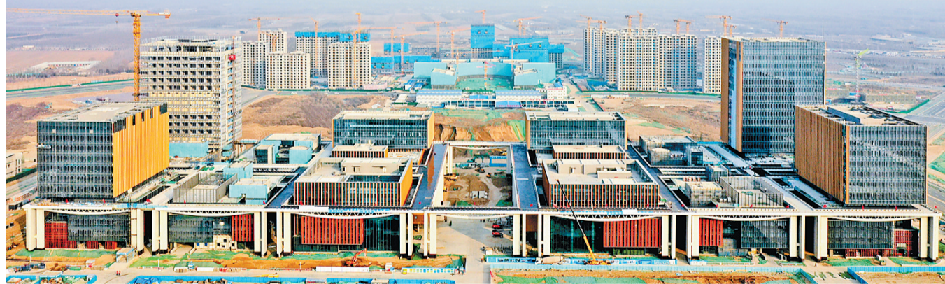
图为即将投入使用的临空服务中心。
