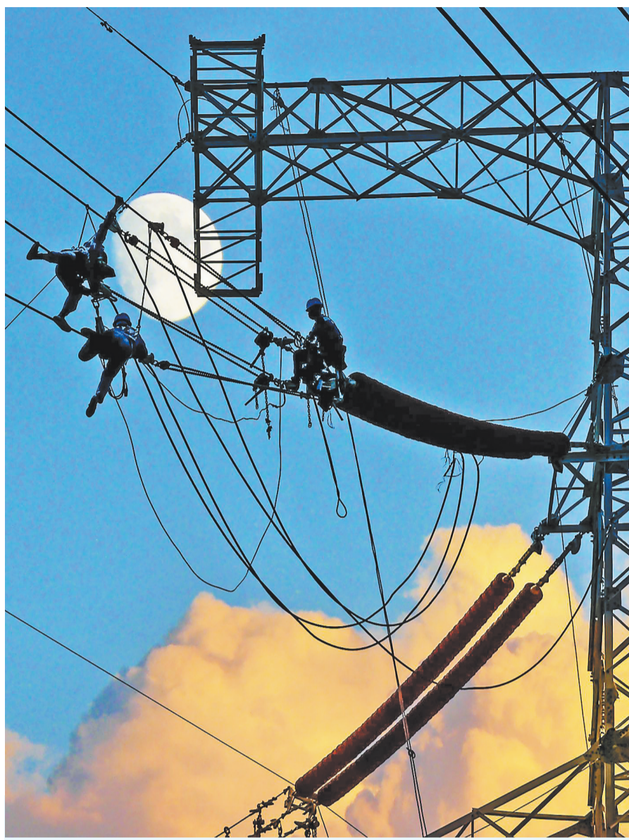
▲张北柔性直流输电工程线路施工现场。 河北日报通讯员 邹明摄 ▶张家口投入运行的氢能燃料电池车。 河北日报通讯员 陈亮摄
