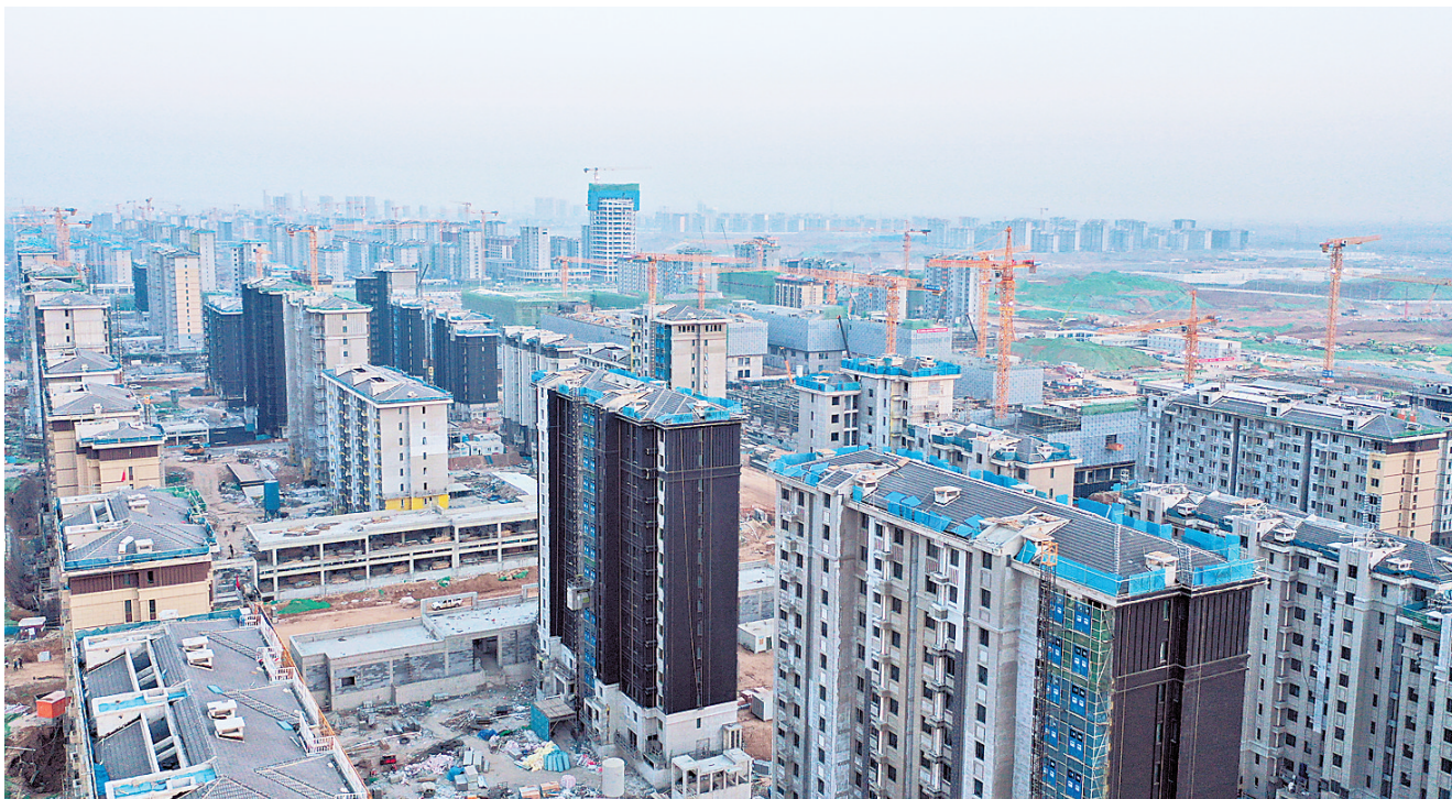
近日,航拍雄安新区容西片区,项目建设有序推进。
