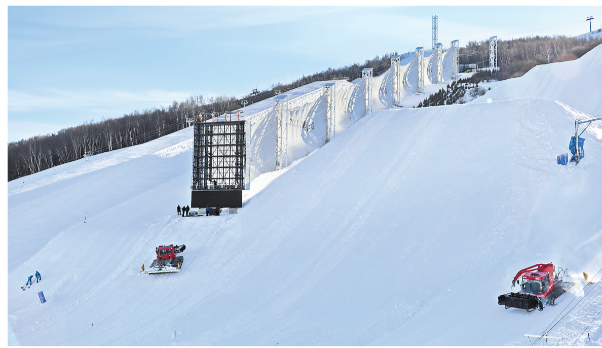
近日拍摄的张家口赛区云顶滑雪公园的防风墙。 日前,防风墙在北京冬奥会张家口赛区云顶滑雪公园亮相。防风墙的建立可以有效地减小大风对运动员的干扰,保证赛事的正常运行。 新华社发(武殿森摄)
