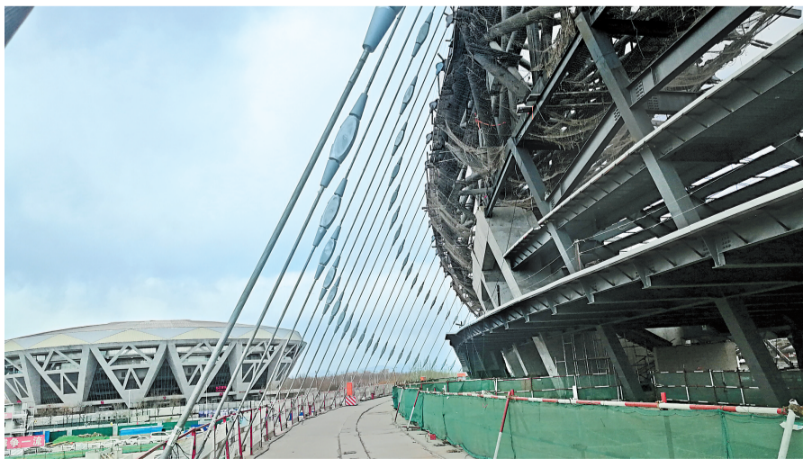
图为巨力集团生产的索具在安装中。巨力集团供图
