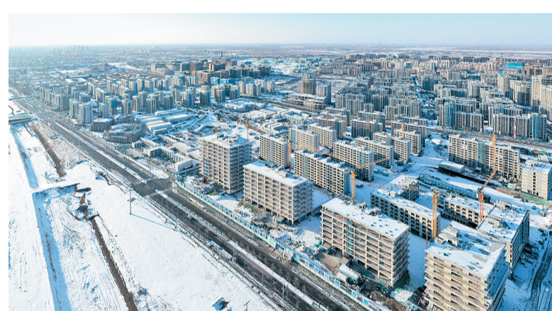
2月14日,雄安新区容东片区建设现场。 河北日报记者 李佳泽摄
