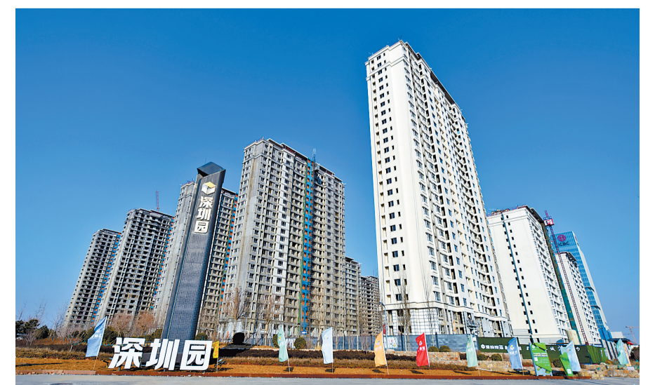
2月24日,由中铁十一局集团承建的保定市深圳高新技术科技创新产业园(简称深圳园)燕云城项目主体已封顶,目前正在进行室内外装修、设备安装等。深圳园是深圳、保定两地合作共建的科技产业新城,总投资约877亿元。根据规划,首先在起步区建设产城融合示范区,打造以电子信息、生命健康产业为主导,全方位、全周期、全配套的产业创新生态体系和集聚区。河北日报记者 赵永辉摄
