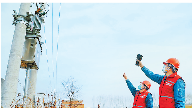
日前,衡水冀州区供电公司加强对所辖线路的巡查,对关系春耕春灌的供电线路和用电设施进行重点检查和维护,确保设备处于最佳供电状态,保障春耕生产用电稳定供应。 河北日报通讯员 王四斐摄
