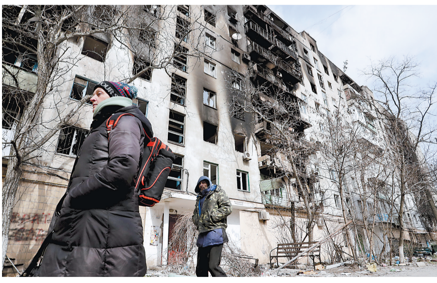
3月25日,人们走过马里乌波尔一栋受损的居民楼。 新华社发(维克托摄)
