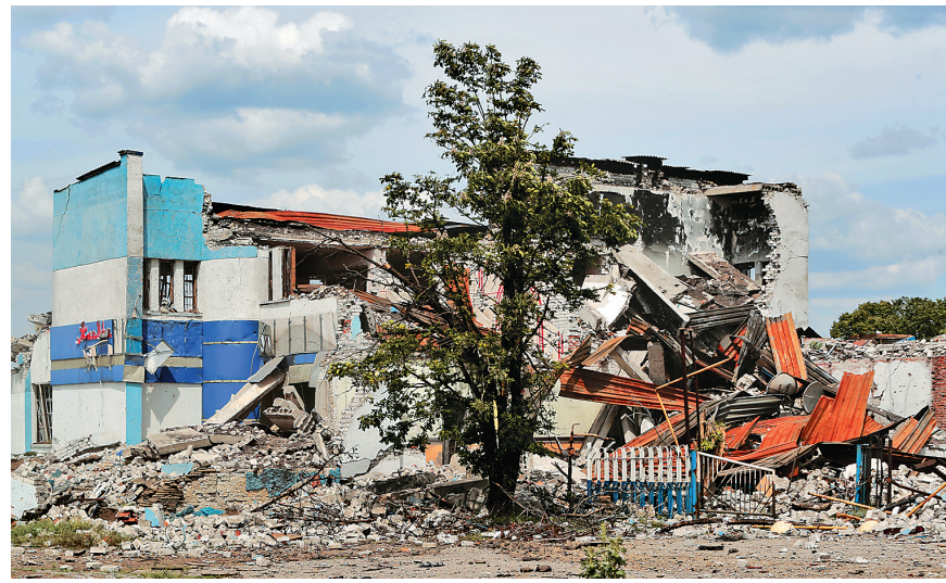
这是5月26日在卢甘斯克波帕斯纳亚拍摄的被损坏的建筑。新华社发(维克托摄)
