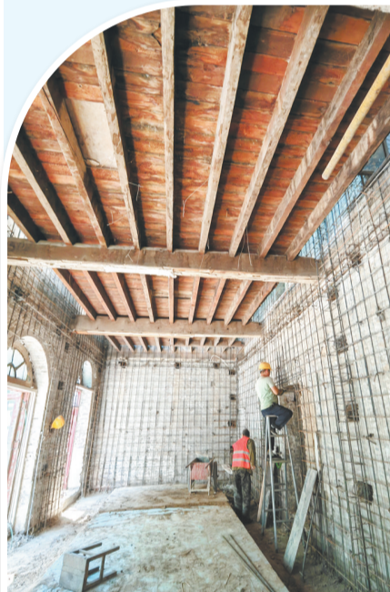
上图:西大街改造提升工程施工现场。
