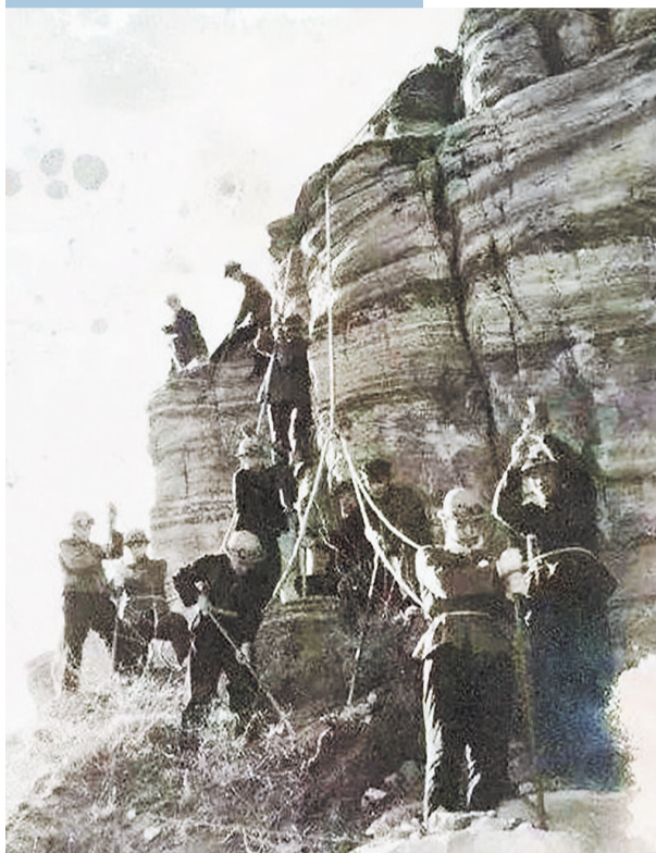
一期工程中,工人在峭壁系绳打钎。
