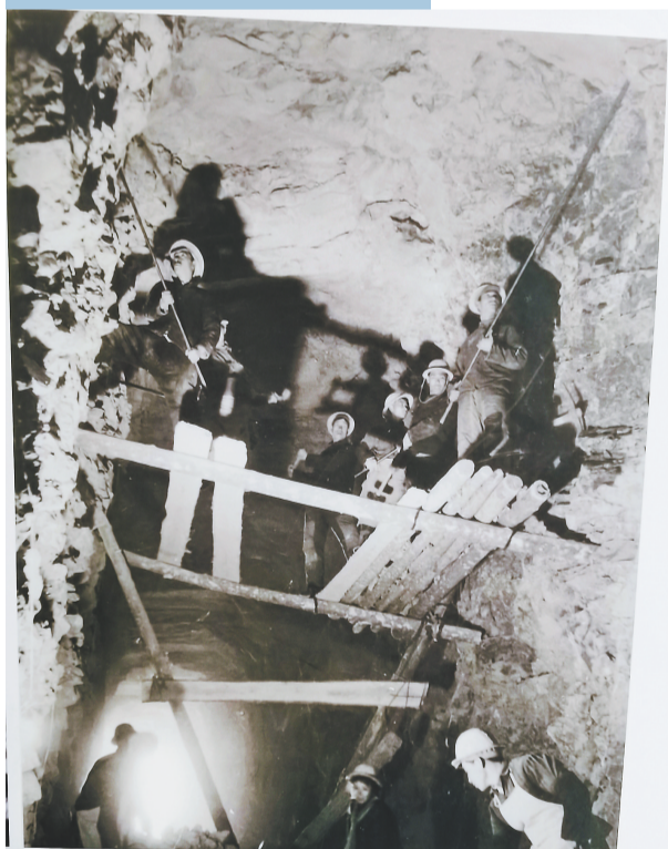
续建工程中,工人逢山凿洞。
