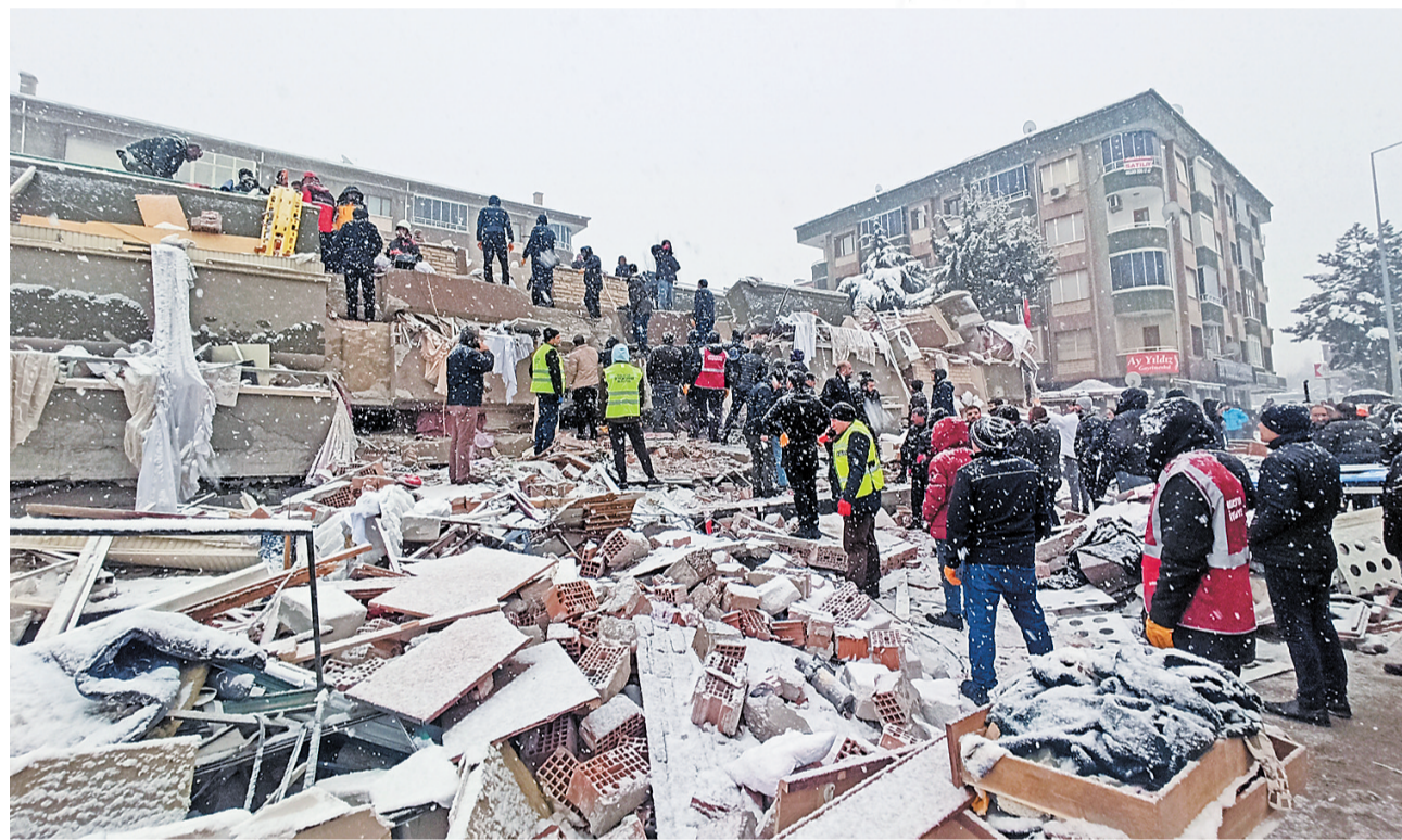
2月6日,人们在土耳其马拉蒂亚一处倒塌的建筑上搜救。
