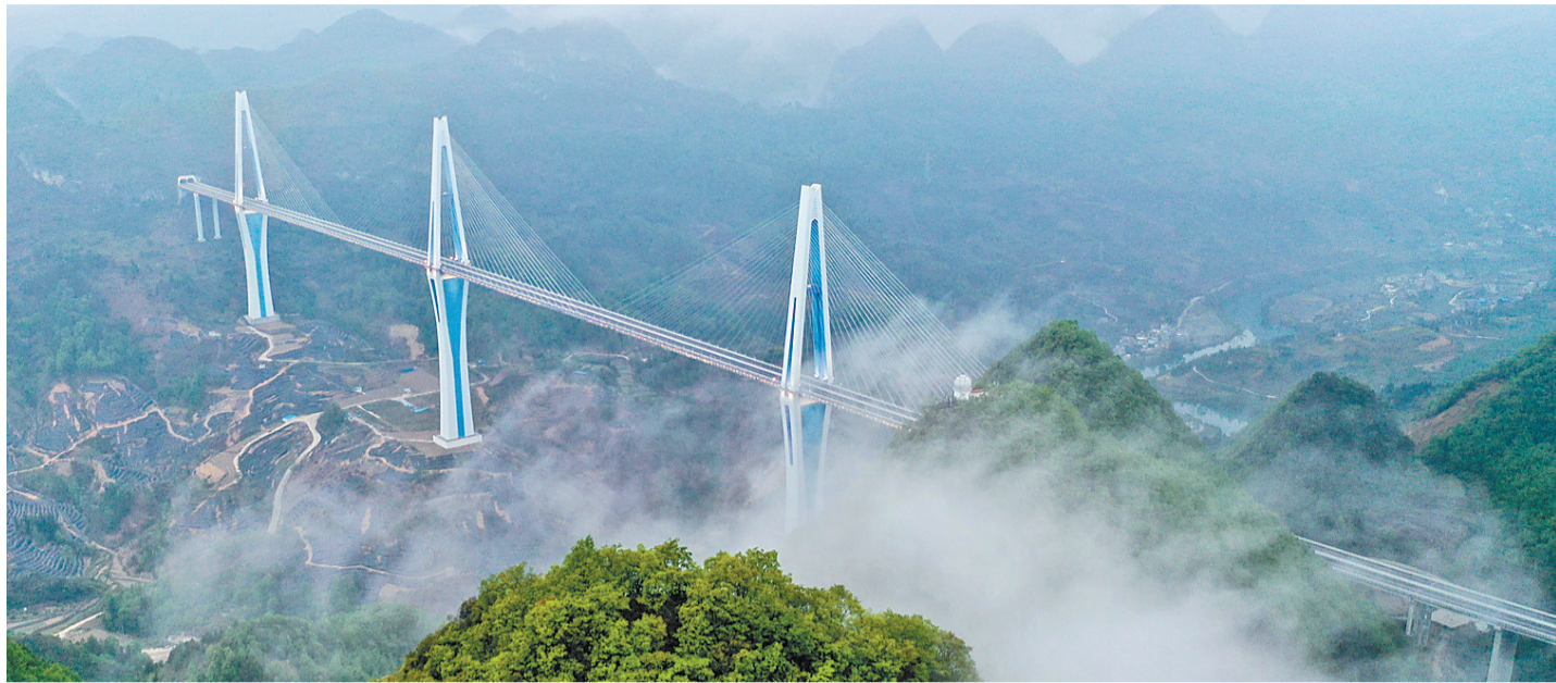
4月14日拍摄的贵州平罗高速公路平塘特大桥(无人机照片)。
