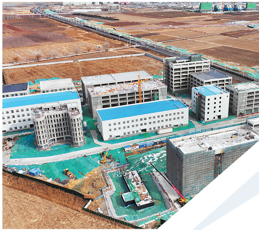
3月4日拍摄的北戴河新区生物制造产业园,该园区正在建设中。
