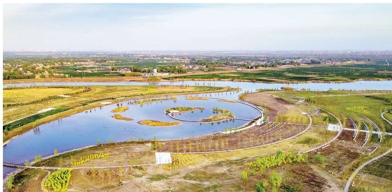
近日拍摄的南拒马河二期生态景观提升工程中的金滩。南拒马河二期生态景观提升工程西起定兴县与容城县交界处,东至东河引水闸,由生态堤与河道滩地两部分组成,工程沿线长约10公里。该项目重要节点——金滩为江湾景观带,重点打造春秋两季植物风貌,春季以野花为主要品种,呈现野花阶、浪漫花海,秋季林、草、田风貌突出北方金秋景观。
