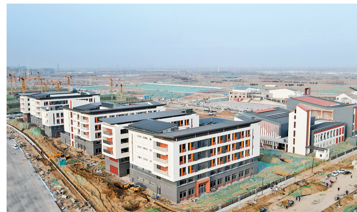
日前,位于雄安新区启动区的北京四中雄安校区已完成主体和外墙装修,正在进行内部精装修施工。北京城建集团北京四中雄安校区项目经理陈昊介绍:“为契合启动区的整体空间风貌和规划设计,北京四中雄安校区采取了传统院落半围合的院落式形制。”河北日报记者 赵海江摄
