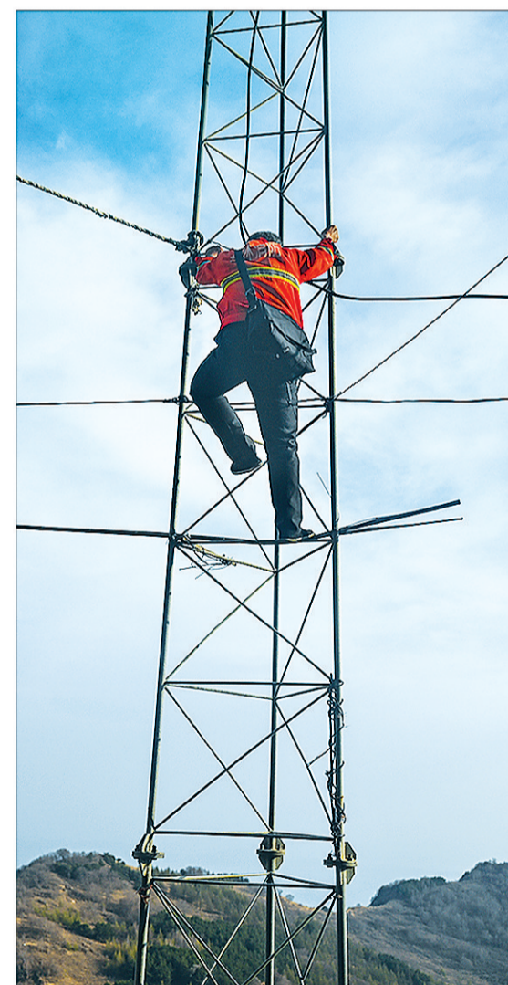
段金龙爬上铁塔维护无线电设备。
