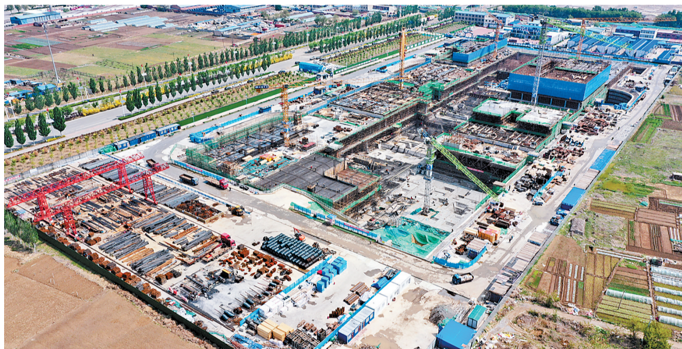
日前拍摄的唐山市中医医院迁建工程项目建设现场。
