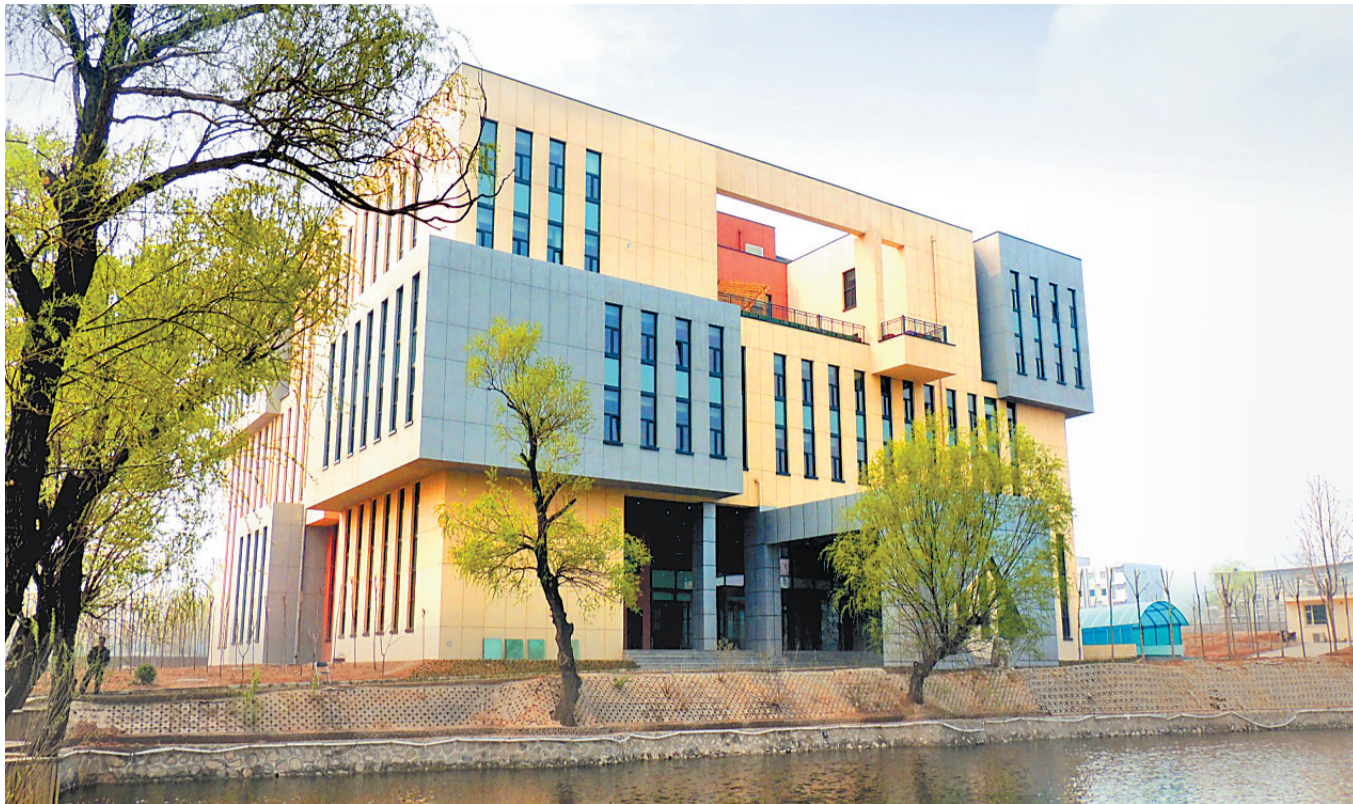
图为河北省建筑科技研发中心中德被动式超低能耗建筑示范房。(本报资料片)
