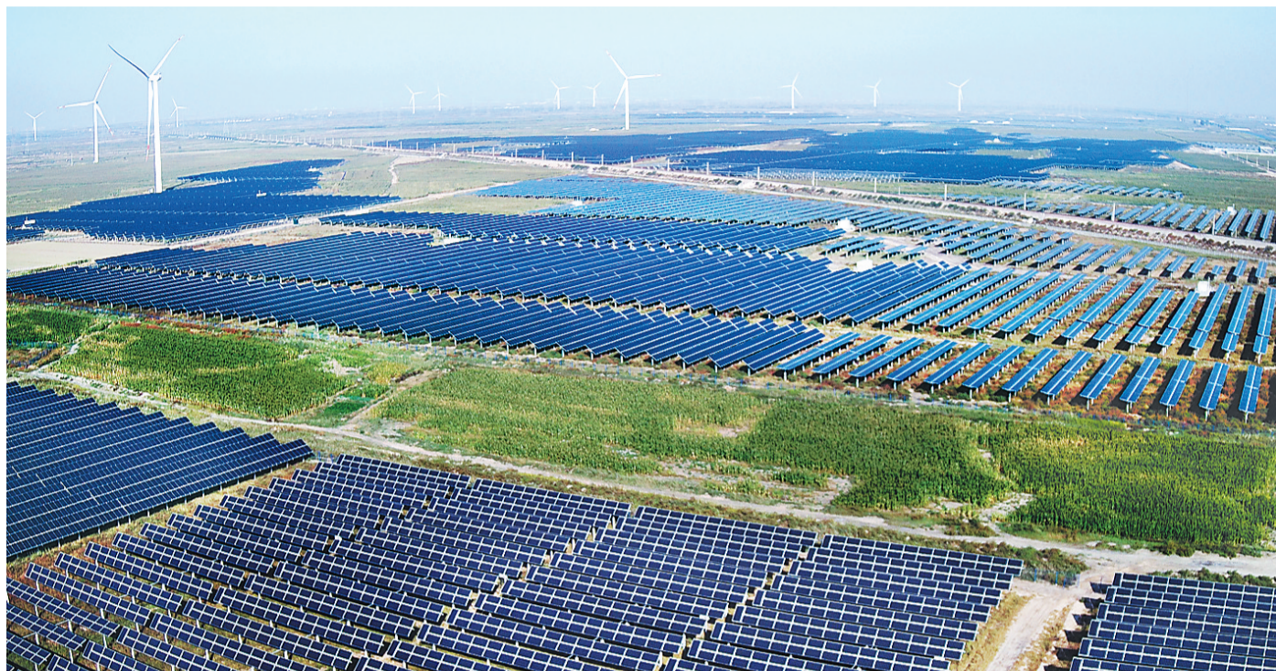
▲工行河北省分行支持的国电投海兴光伏发电项目。
