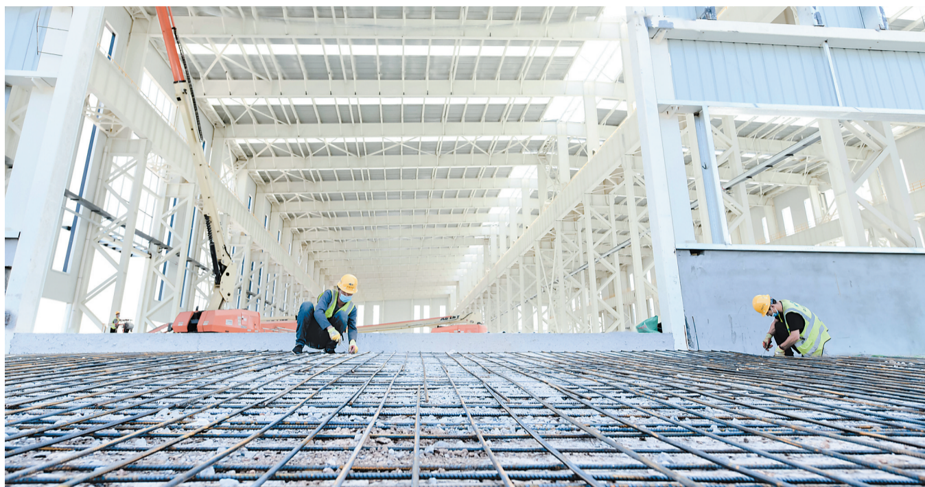
冀南新区运达风电高端装备制造产业园一期项目将于今年6月底投产。图为工人进行厂房地面钢筋绑扎铺设。 周景泽摄
