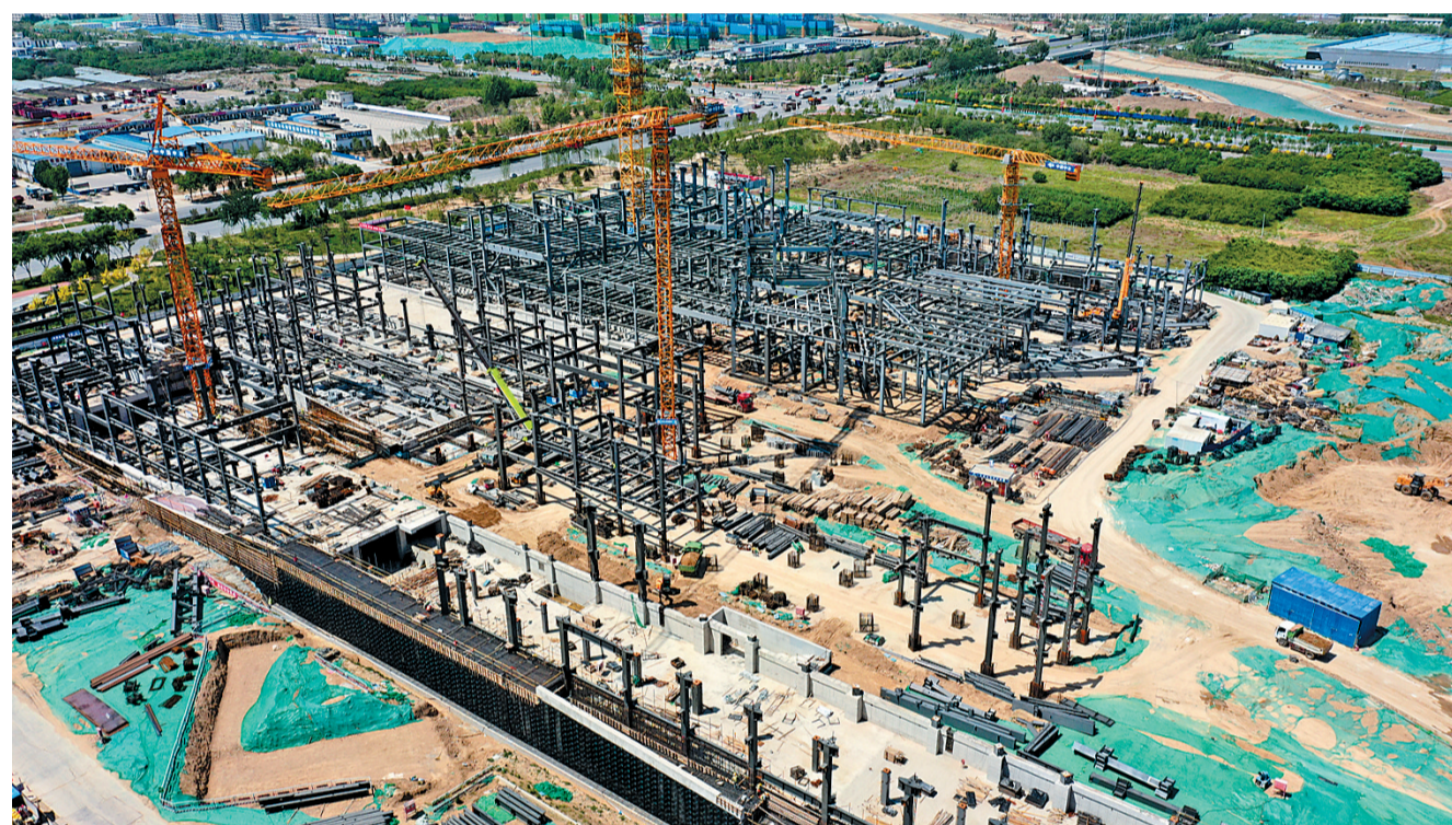
正在建设中的中国古动物馆·保定自然博物馆。
