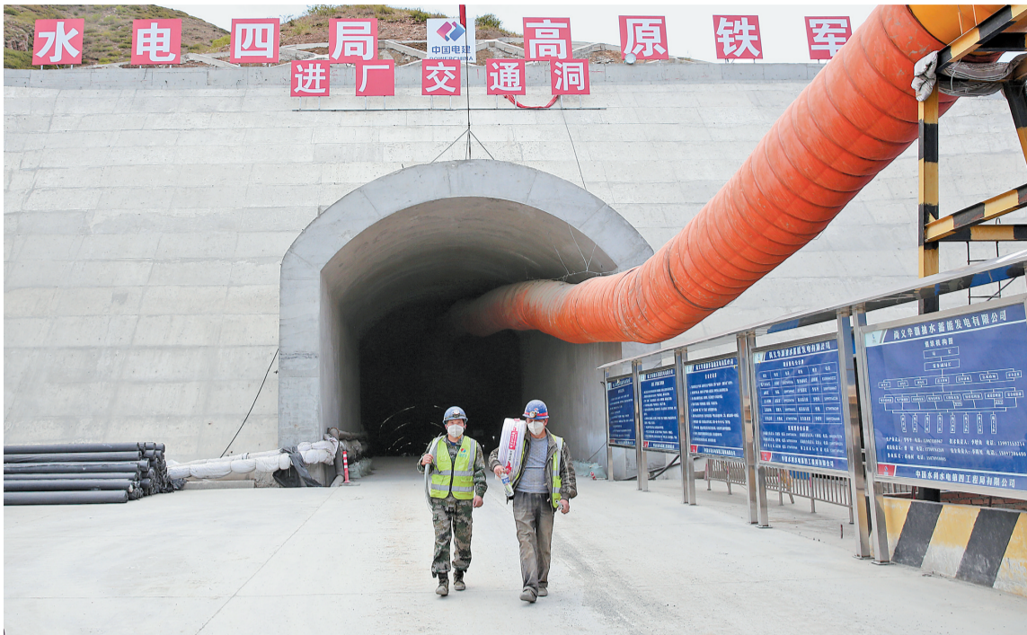
图为建设中的进厂交通洞。 河北日报 通讯员 李登峰摄
