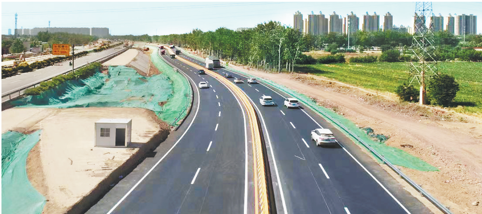
近日,石家庄市南二环东延线与复兴大街互通立交匝道及附属工程保通路正式开放通行,这也是复兴大街市政化改造工程首段通车的保通路,标志着该工程正式进入主体开挖施工阶段。 河北日报通讯员 邢宇森摄
