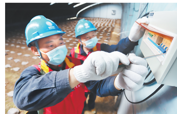
日前,国网临西县供电公司建立党员服务队,深入田间地头和乡村工厂,开展农村生产用电安全大检查。这是党员服务队队员在为东苑食用菌种植棚检修配电设施。 河北日报通讯员 张玉坤摄
