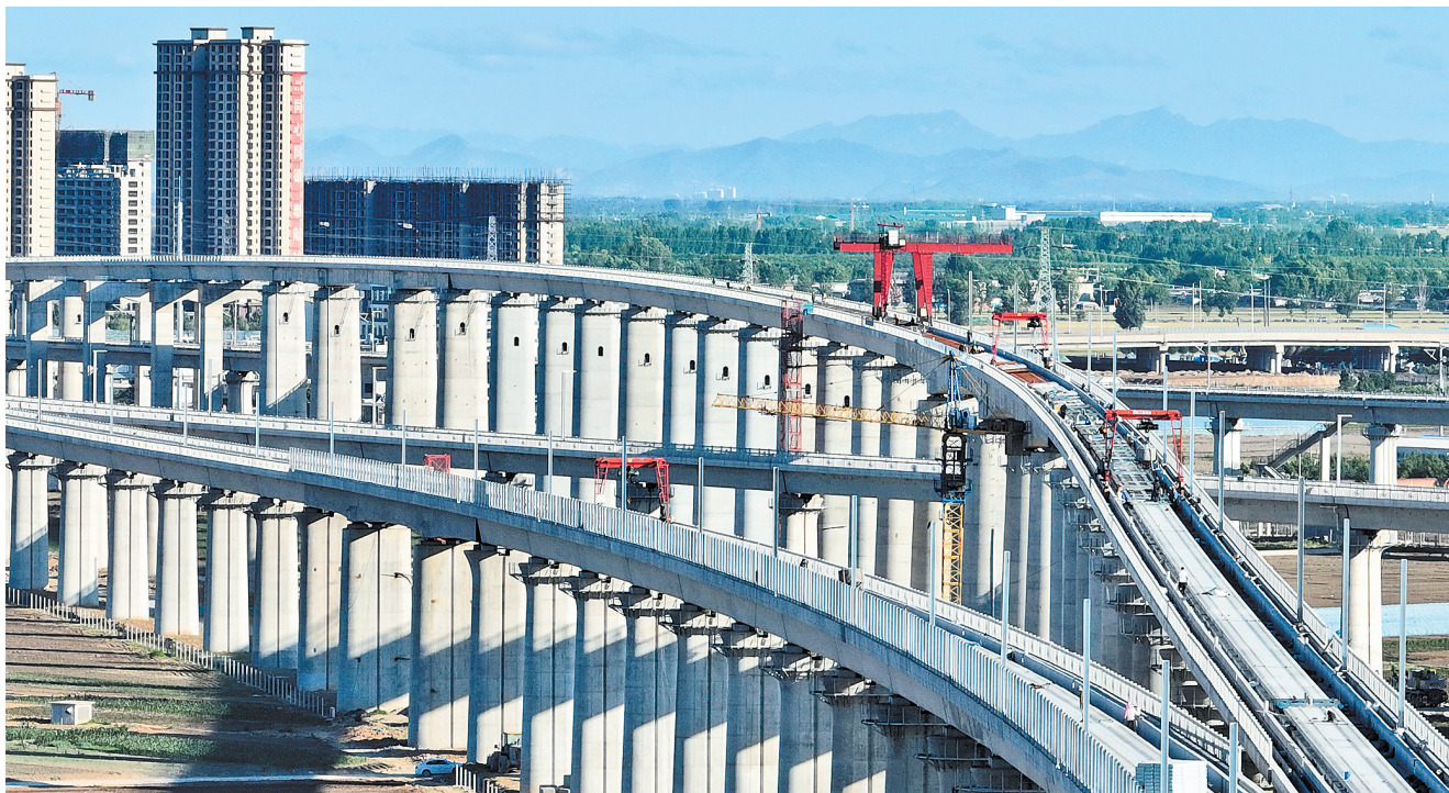
6月7日,工人在唐山市高新技术开发区境内的京唐城际铁路建设工地施工(无人机照片)。
