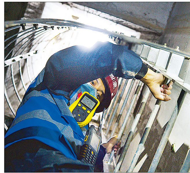
▲牛士洪通过检查井的扶梯进入管廊内部。 ▲雄安副村城市智慧能源融合站地上部分是一座开放式绿色景观花园广场,地下部分设有智能充放储电站、综合能源服务站、绿能健身体验馆等完备的多功能设施。 ▼2号能源站内,工作人员进行检修作业。
