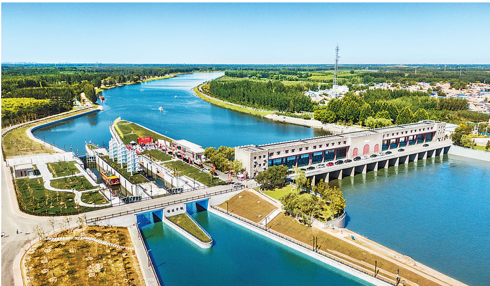
位于大运河京冀交界处的北京杨洼船闸。
