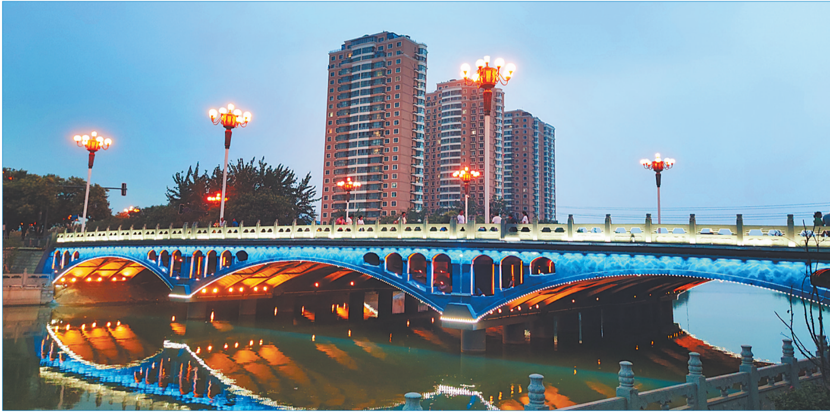
近日,由中铁二十二局集团有限公司承建的沧州市中心城区大运河文化战略与通航项目的亮化工程正式亮灯。该项工程的完成,将为历史文化底蕴深厚的大运河增添光彩,进一步提升沧州市的城市形象。 河北日报记者 王雅楠摄
