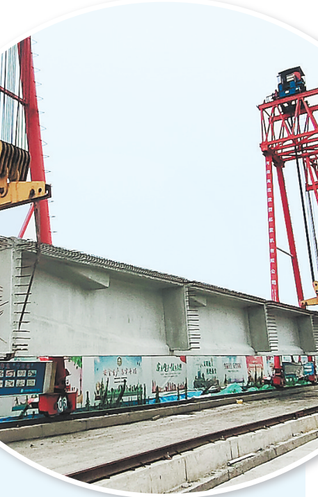
日前,邯郸市主城区大外环国道G107项目南湖特大桥梁板预制施工全部完成。 河北日报通讯员 李楠摄
