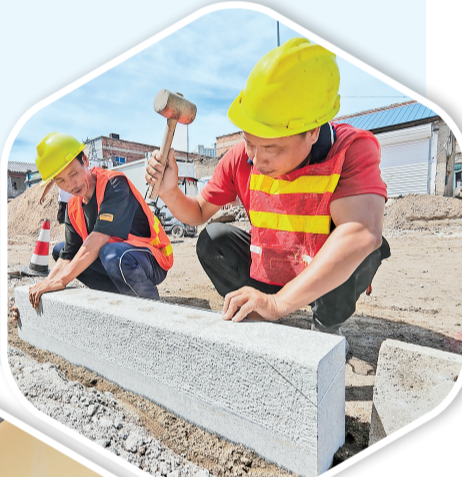
有工人在铺设路缘石。
