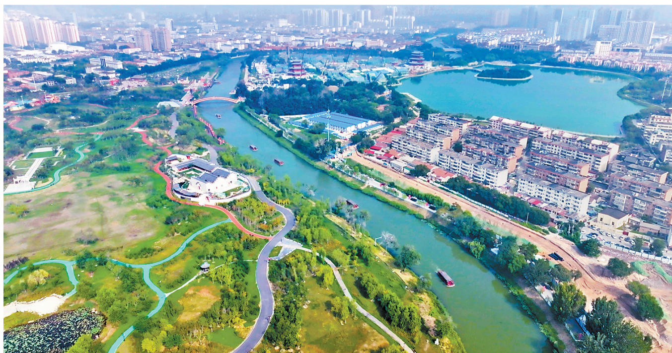
9月1日，京杭大运河沧州中心城区段实现旅游通航。
