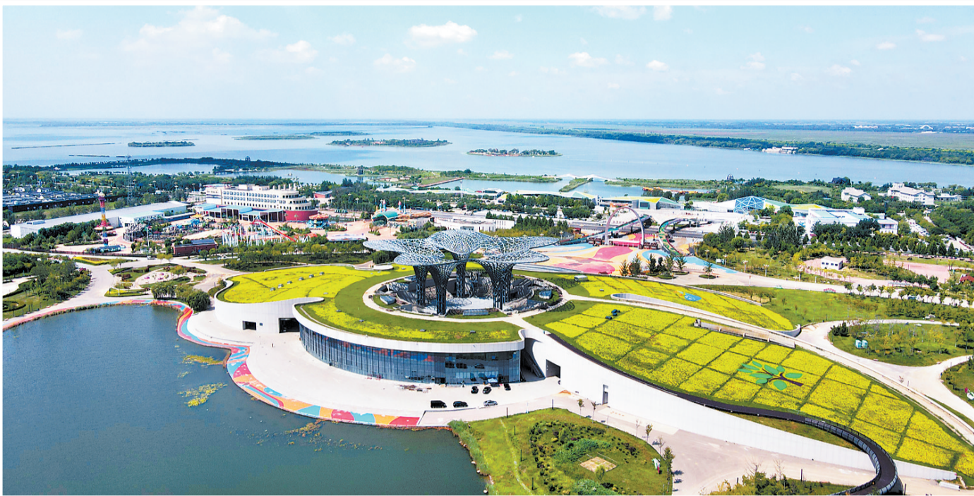
▲景色怡人的衡水湖与衡水园博园遥相呼应。 ▶今年以来,衡水市全力推进衡水湖国家5A级旅游景区创建各项工作。这是冀州区环湖绿道提升工程项目施工现场。 本组图片由河北日报记者焦磊摄
