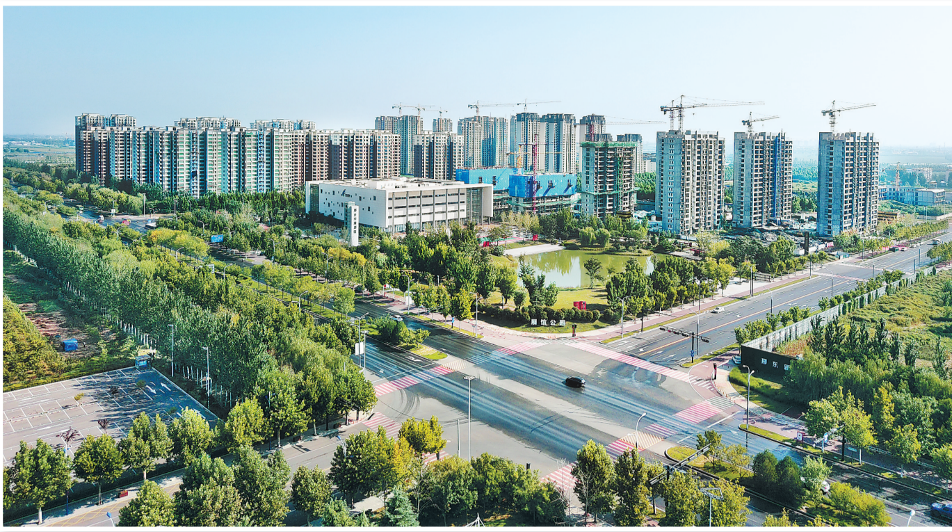
上图:正在建设中的邢东新区。
