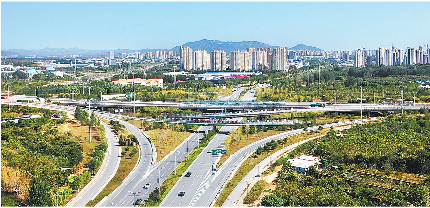
上图:近年来,秦皇岛市不断优化交通基础设施布局、结构、功能,加快构建高质量综合立体交通网。这是秦皇岛市宁海大道与兴凯湖路交叉立交桥。 中图:在秦唐高速秦皇岛段,工人绑扎预制箱梁底板钢筋。 下图:如今,秦皇岛市干线公路网四通八达,市民出行更加便利。这是经济技术开发区的兴凯湖路。
