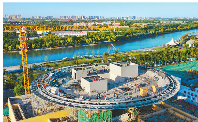
↑太平河城市片区展示中心主体封顶,正在进行精装修施工。
