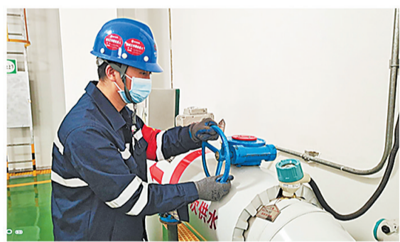
国家电投热力公司“供热管家”底宏伟对换热站二次供水进行调整。
