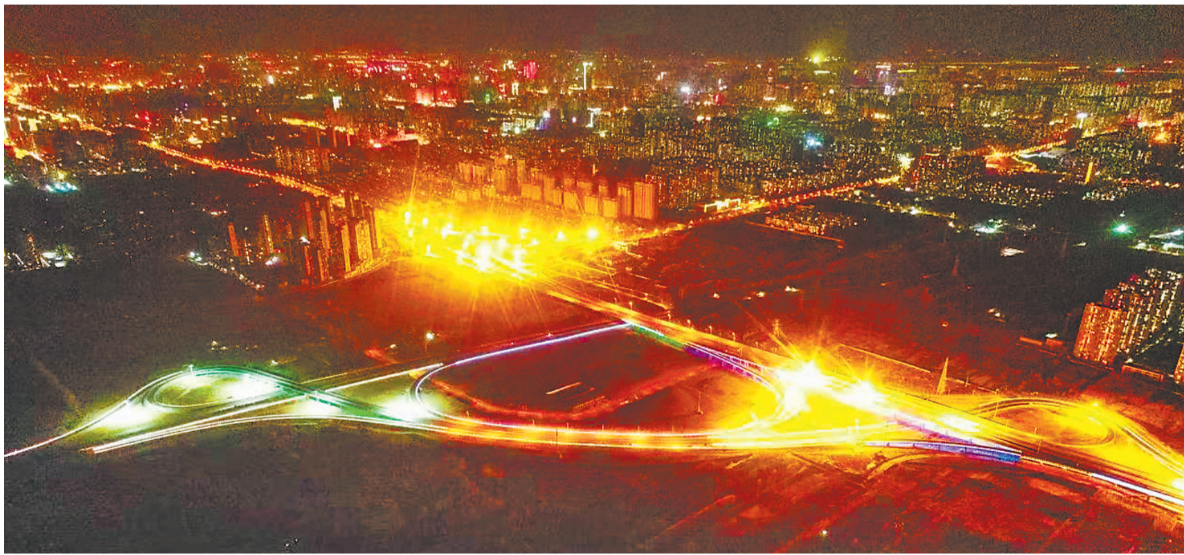
近日,石家庄市南二环东延与复兴大街互通立交亮化工程正式完工,为石家庄市东南部交通增添了靓丽色彩。 河北日报通讯员 邢宇森摄
