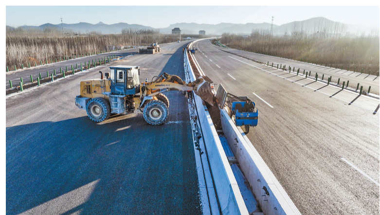
12月7日,工人操作设备在京秦高速遵秦段进行境内施工(无人机照片)。京秦高速遵秦段全长约165公里,预计2022年底建成通车。
