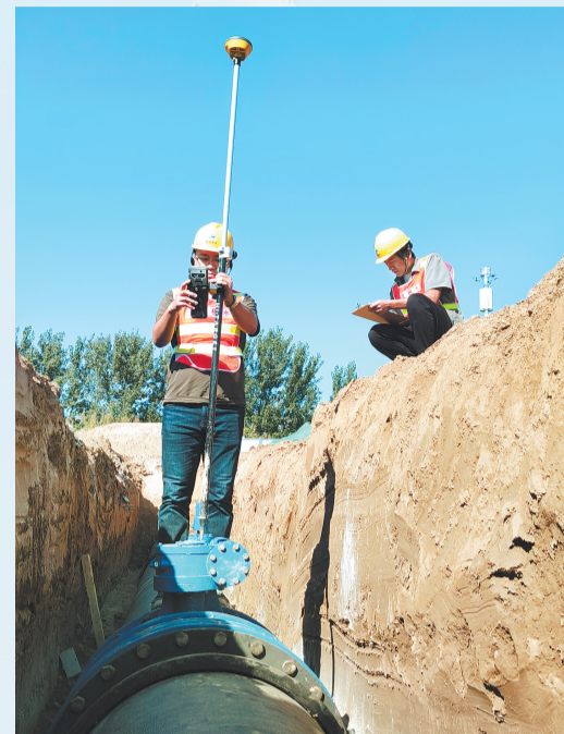
对恒源路新建DN800管道进行定位测绘。
