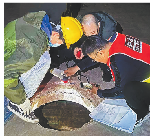
夜间对抄表到户小区管道进行漏点检测。
