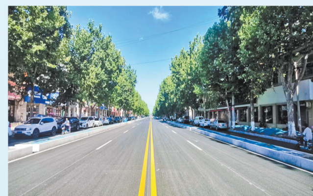
内黄县朝阳路主路面通车。
