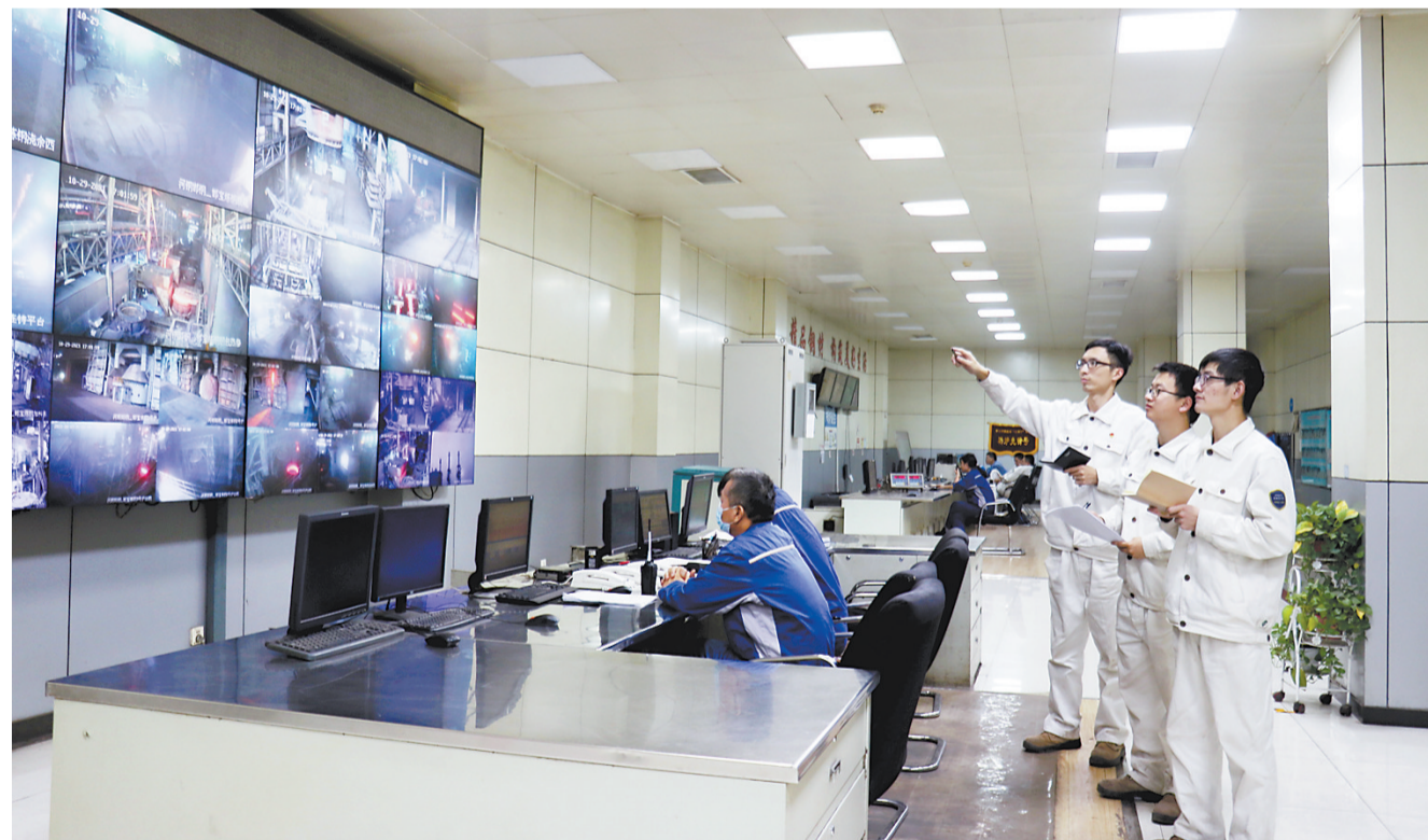
邯宝炼钢厂转炉主控室内,技术人员在了解生产情况。
