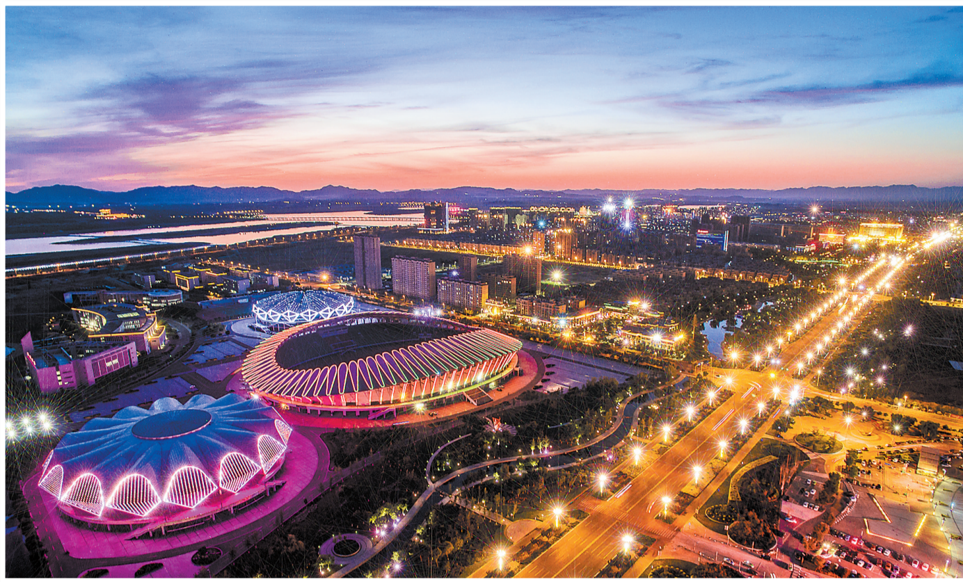
▲聚焦“北方水城、美丽迁安”城市定位,迁安市强力推动产城融合,促进城市高质量发展。这是夜幕下的迁安奥体中心。河北日报通讯员 李彬摄 ▶在唐山科源激光再制造有限责任公司80吨高速动静平衡检测中心车间内,工人正检修设备。河北日报通讯员 陈儒摄 ▼首钢智新生产线。河北日报通讯员 陈儒摄
